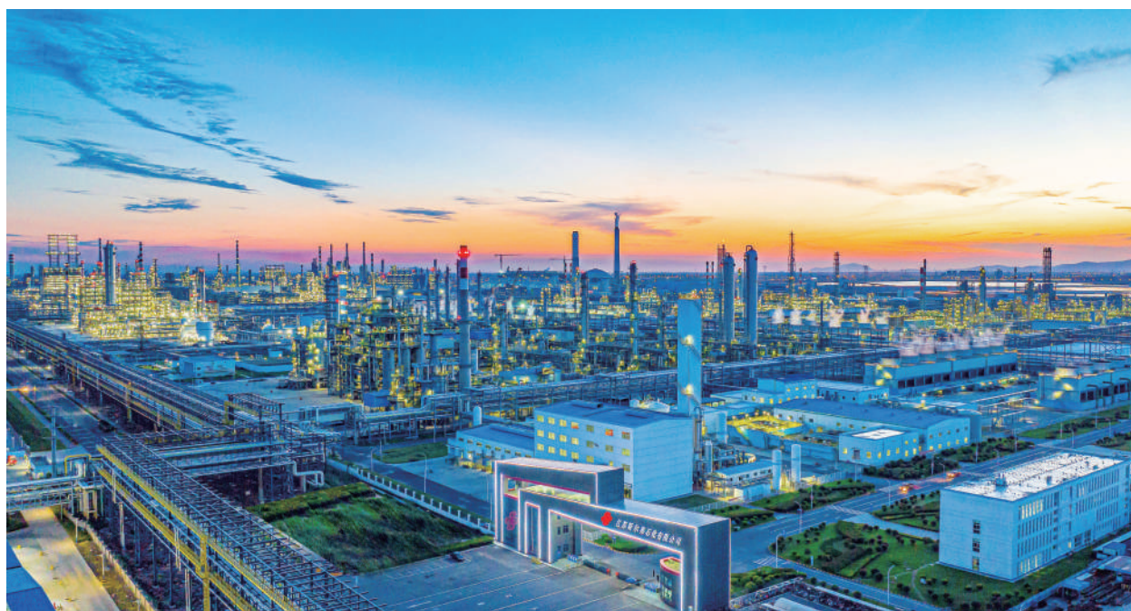
● 连云港石化产业基地
